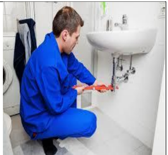
INSTALACIÓN DE SANITARIO
